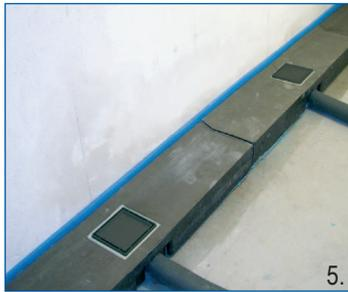
**РЭС** Установить в трап надставной элемент со строительной заглушкой, канализационную трубу изолировать утеплителем
