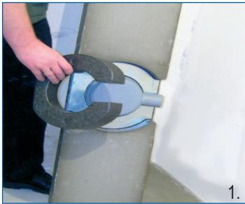
**РЭС** Определиться с направлением выпуска трапа, зафиксировать с помощью кольца
