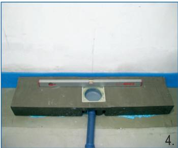
**РЭС** Приклеить монтажную плиту трапа, проверить горизонтальность установки, подсоединить канализационную трубу (DN50 уклон 3%)
