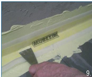
**РЭС** Гидроизолировать с помощью ленты и герметика стык монтажной плиты со стеной
