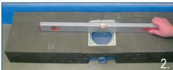
**РЭС** Установить демпферную ленту между стеной и монтажной плитой трапа. Проверить горизонтальность установки монтажной плиты.
