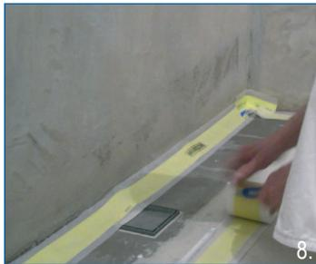
**РЭС** Гидроизолировать с помощью ленты и герметика стык монтажной плиты с полом
