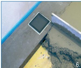
**РЭС** Звукоизолировать пол, залить раствором с уклоном мин. 1,5% к верхнему краю монтажной плиты трапа
