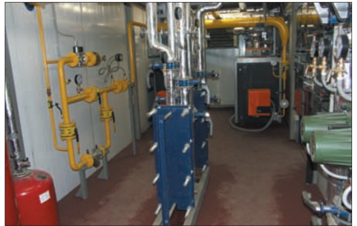
Размещение котельного и технологического оборудования внутри блок-модуля
