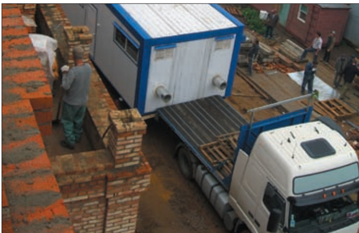
Транспортировка блочно-модульной котельной на объект
