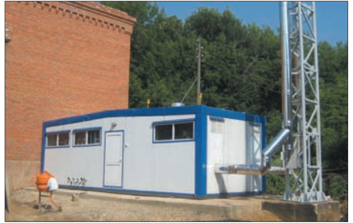
«Свято-Троицкая Сергиева Лавра», г. Сергиев Посад, МО (БМК ) котельная 1,02МВт
