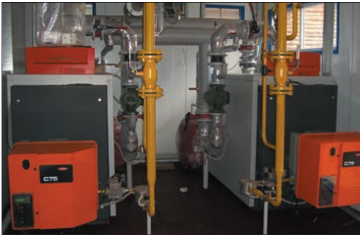
Размещение котельного и технологического оборудования внутри блок-модуля
